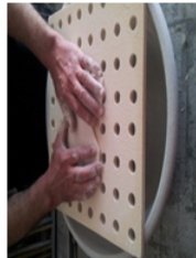
Şekil 12: Kuruyan alt yapının tesviyesi
