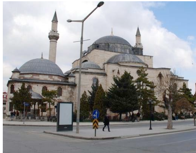
Resim 10 Konya Selimiye Camisi Güney Cephesi.
