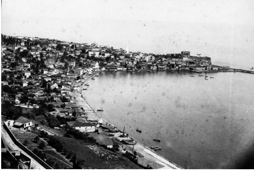
Foto 18: Çömlekçi Mahallesi (Çömlekçi District)
