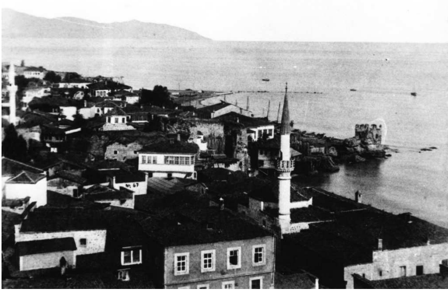
Foto 19: Çömlekçi Mahallesi (Çömlekçi District)
