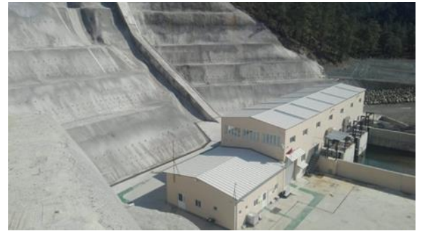
Şekil 5. Namnam HES binası ve cebri boru
