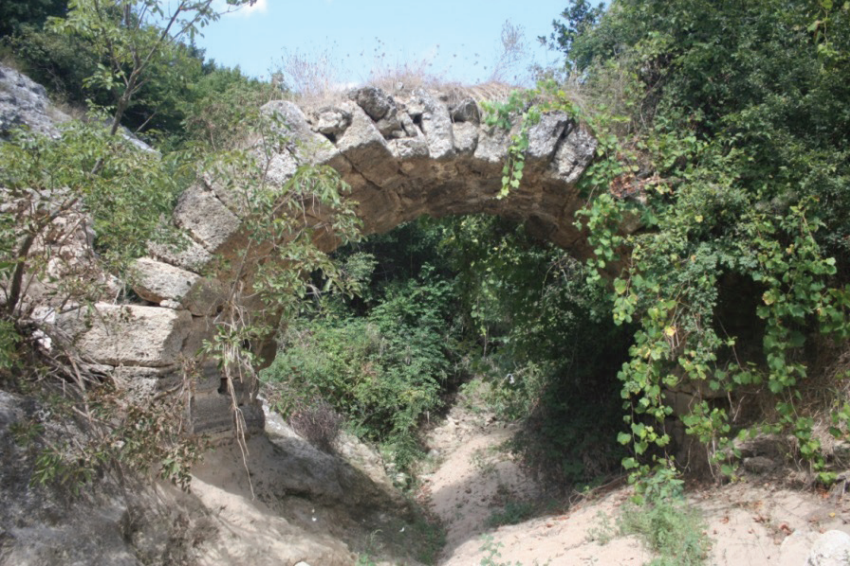
Resim 1: Kurtdere Köprüsü (Güneyden)
