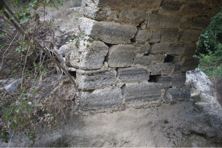
Resim 2: Kurtdere Köprüsü, Batı Ayağı
