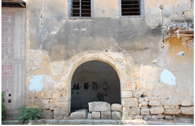
Fot. 2: Kuzeydoğu Köşedeki Mekana Giriş
