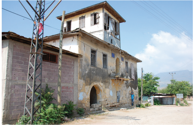
Fot. 3: Kuzey Cephe
