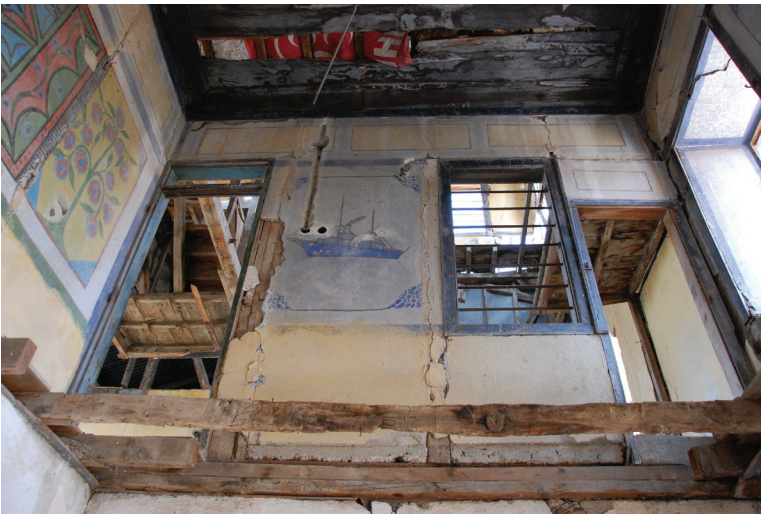
Fot. 6: Birinci Kat Kuzeydoğu Köşedeki Mekanın Batı Duvarı Kalemişi Süsleme
