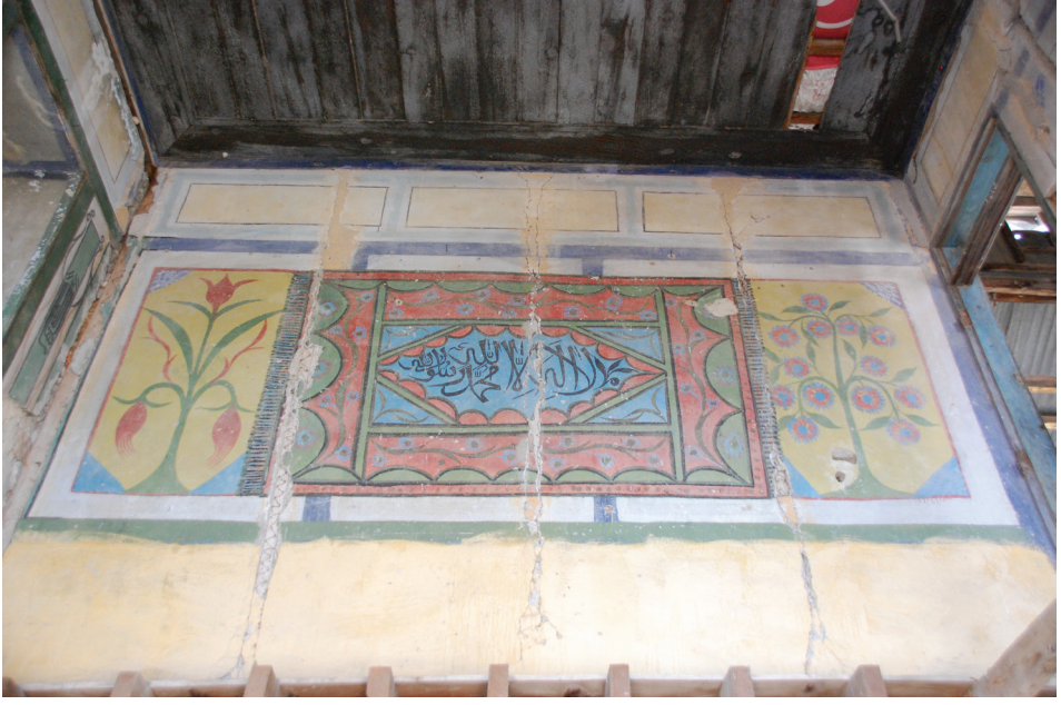
Fot. 7: Birinci Kat Kuzeydoğu Köşedeki Mekanın Güney Duvarı Kalemîşi Süslemeler
