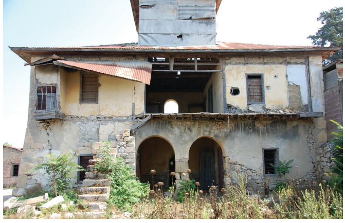
Fot. 1: Güney Cephe ve Birinci kata Çıkış Merdiveni
