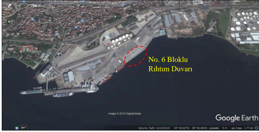
Şekil 2. Derince Limanı uydu görüntüsü ve bloklu rıhtım duvarı konumu
