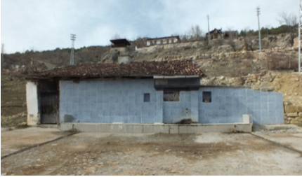
Fot. 29: Güney cephe görünümü
