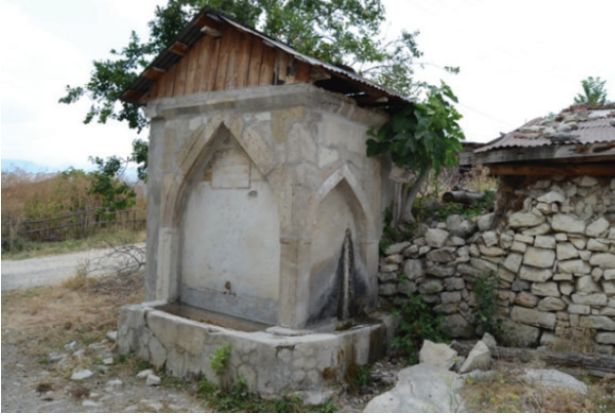
Fot 16: Güneydoğudan görünüm
