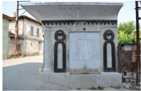
Fot. 36: Doğu cephe görünümü
