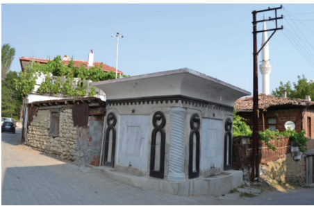
Fot. 35: Güneydoğudan görünüm
