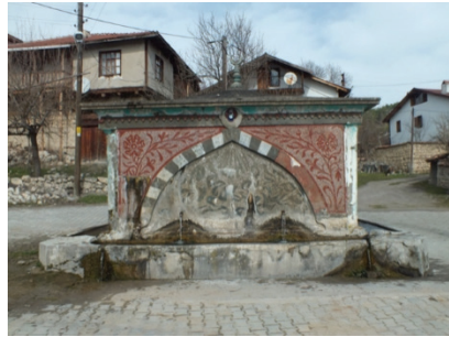
Fot. 32: Güney cephe görünümü
