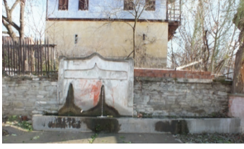
Fot. 28: Batı cephe görünümü
