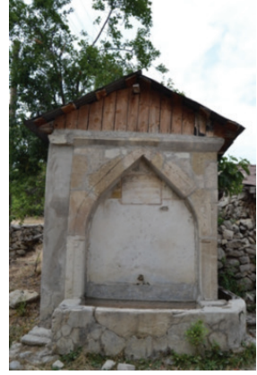
Fot 17: Güney cephe görünümü
