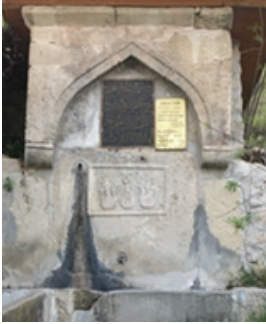
Fot. 7: Güney cephe görünümü
