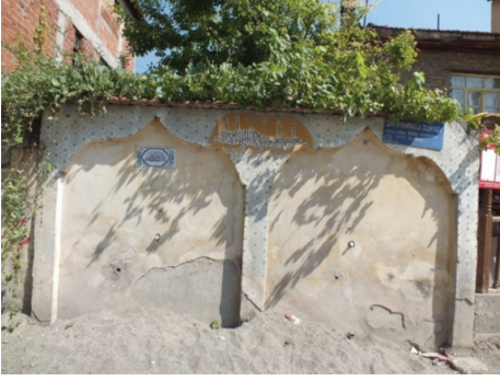
Fot. 26: Güney cephe görünümü (2015)
