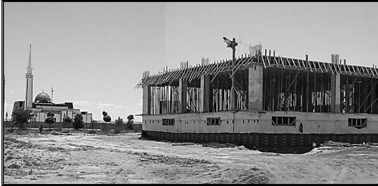
Fakülte binamızın inşaatı. 17.06.2014
