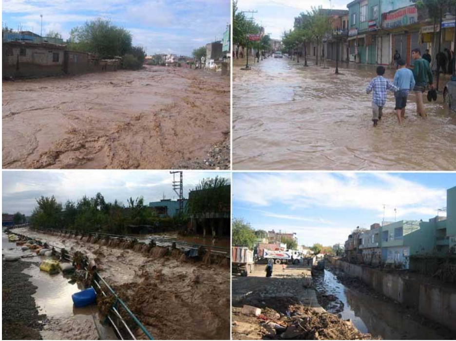
Foto 4. Batman'da 2006 yılında yaşanan taşkında kanalın kapasitesinin yetersiz olduğu görülmüştür. Yaşanan taşkında kanaldan taşan su çevreye büyük zara vermiştir.
