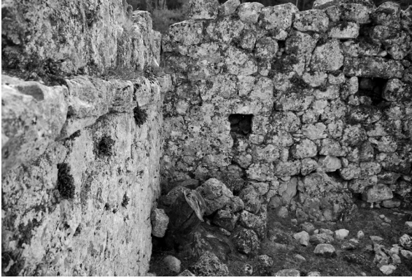
Res. 19 Muskar-Alakilise yolu üzerinde tek odalı konutun kat ayrımını gösteren konsol düzenlemesi
