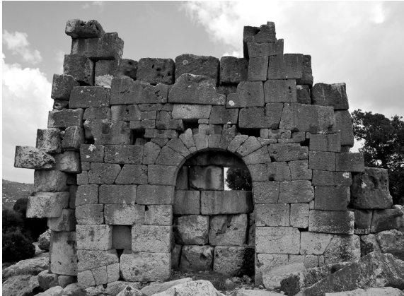
Res. 12 Kurşun Kalesi Tapınağı, kuzey duvar iç cephesi, güneyden görünüm.
