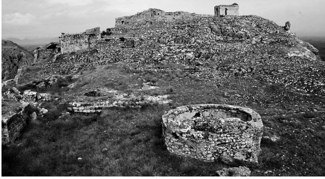
Res. 24 Anavarza Kalesi, iç kaleden kuzeye doğru genel görünüm, ön plandaki silindirik yapı kalıntısı bir sarnıçla bağlantılı su tesisi olabilir (D. Davtyan – KMKD arşivi)
