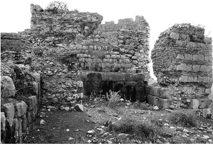
Res. 7 Anavarza Kalesi girişinde güney doğudan farklı inşa dönemleri gösteren sur kalıntısı (E. Hançer – KMKD arşivi)
