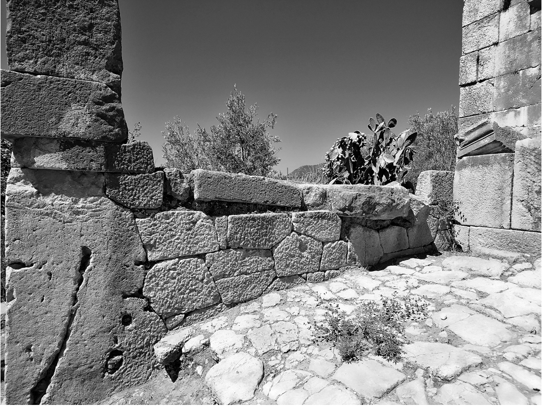
Res. 9 Batı Kule, Açıklık İçine Bakan Polygonal Duvar Örgüsü, Ksanthos Kazı Arşivi
