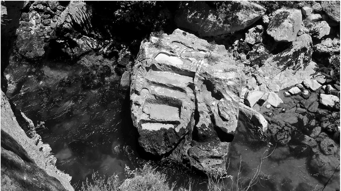
Abb. 7 Als Brückenwiderlager dienender Felsblock am Ostufer des Melas.
