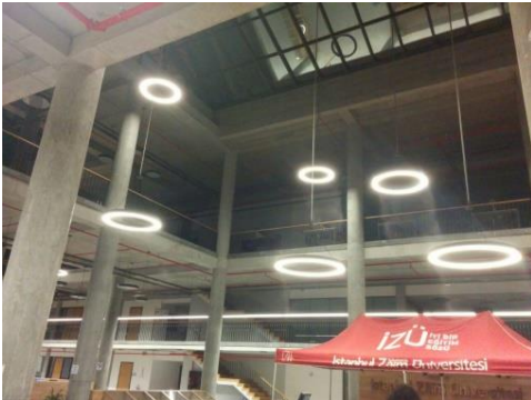
Şekil 6. Büyük galeri boşluğundan görünüm
