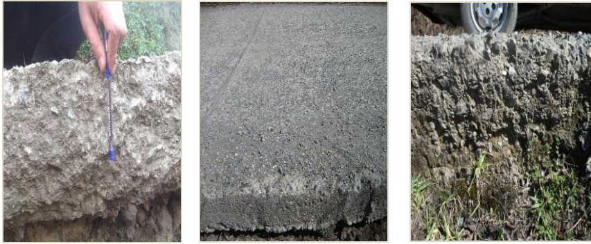
Şekil 9. Trabzon İlinde farklı beton yollar
