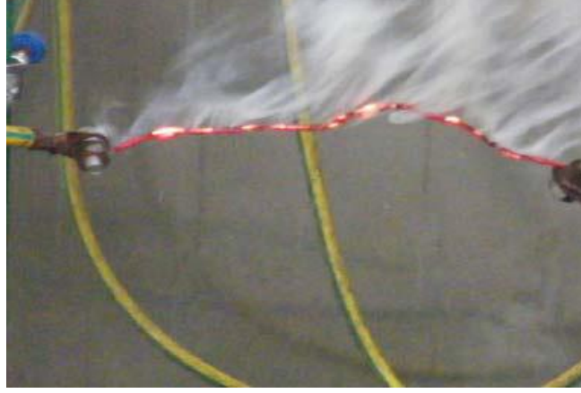
Resim 1. Aşırı akım çekilen kablo yangını
