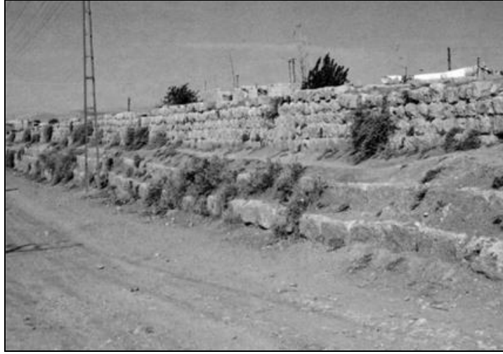
Resim 1. Şanlıurfa Justinien su bendi (kaldırım) [17] (Photo 1. Şanlıurfa Justinien weir(pavement) [17])
