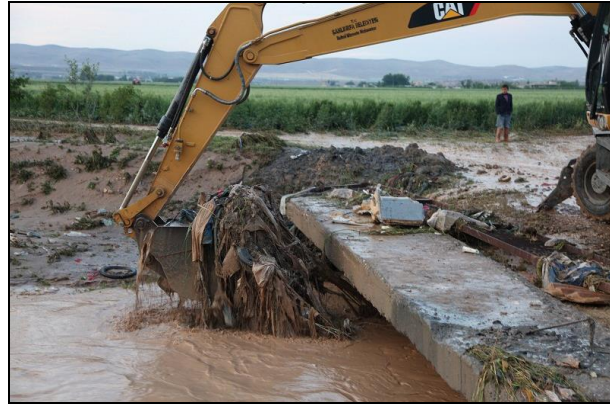
Resim 8. Menfezi tıkayan atıklar ve kesit daralması nedeniyle taşan kanallar [5] (Photo 8. Because of cross-section narrowing and wastes which occlude culvert, the channels overflow [5])
