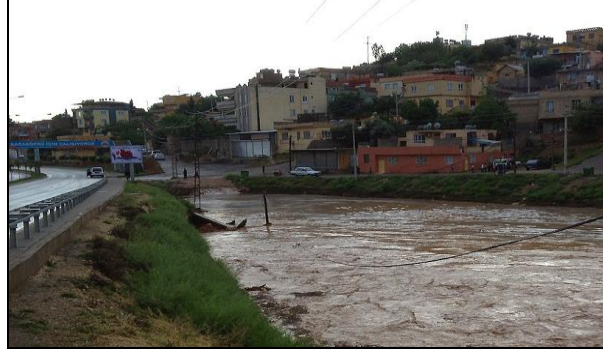
Resim 4. Köprü kesitinin yetersizliđi ve kesiti daraltan unsurlar nedeniyle akışın köprü girişinde birikmesi-Karaköprü Deresi ile Şanlıurfa-Diyarbakır yolunun kesişme noktası [5] (Photo 4. Because of the cross section of bridge insufficiency and the elements which reduce cross-section, the flow is collected in the entrance of the bridge-Conflux of Şanlıurfa-Diyarbakır road and Karaköprü River [5])
