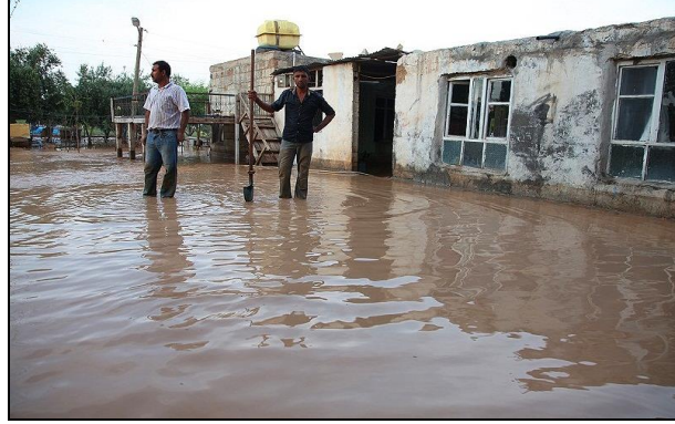
Resim 7. Bozova-Yaylak'ta taşkından zarar gören bir ev [5] (Photo 7. The house which damaged by flood in Bozova-Yaylak [5])
