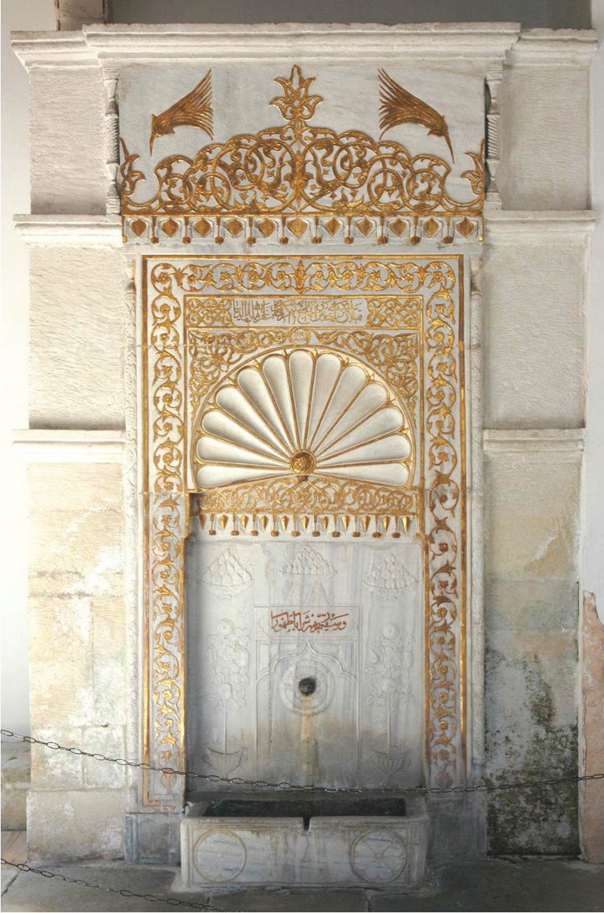
Fot. 3: Hansaray, Altın Çeşme. Genel görünüş.
