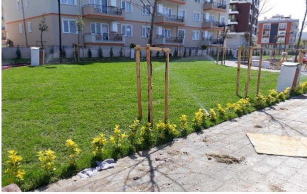
Şekil 24. Rotor Yağmurlama Başlıkları
