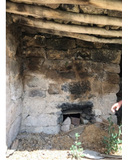
Görsel 10. Fırın yükleme ve boşaltma işleminin yapıldığı üst kapak.
