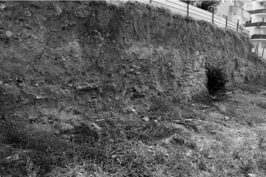
Levha 5.2. III ve IV no'lu duvarlar. I ve II no'lu Mekanlar Genel Görünüm.
