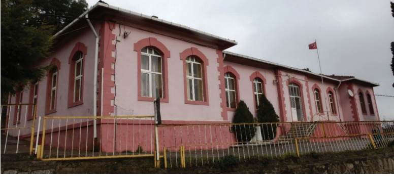
Fot. 5: Mehmet Akif Ersoy Ortaokulu Güney Cephesi
