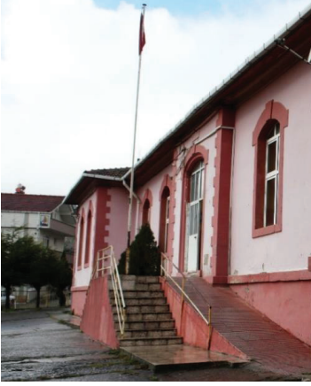
Fot. 6: Merdiven Basamakları ve Engelli Rampası
