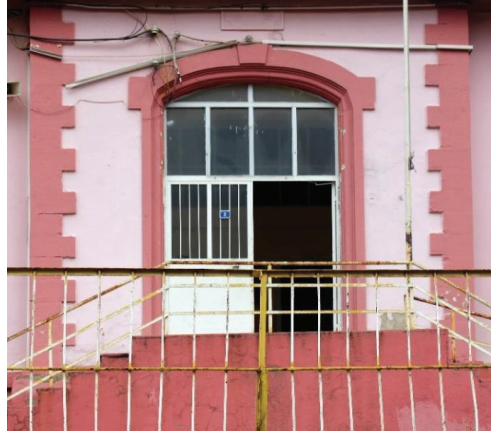
Fot. 7: Güney Cephedeki Kapı Açıklığı
