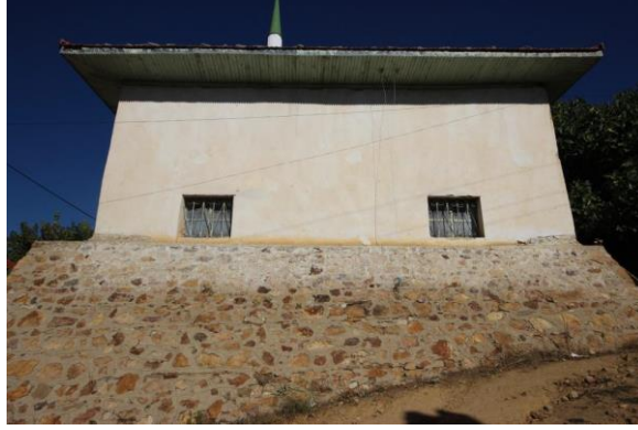
Resim-2: Kışlak Eski Camii Güney Cephesi Görünümü.
