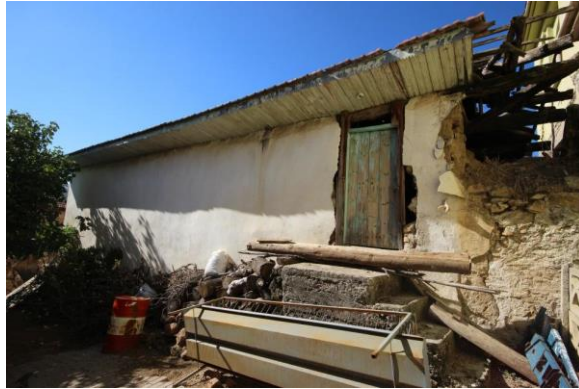
Resim-3: Kışlak Eski Camii Doğu Cephesi Görünümü.
