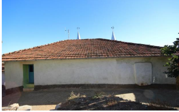
Resim-26: Ahatlar Camii Kuzey Cephesi Görünümü.
