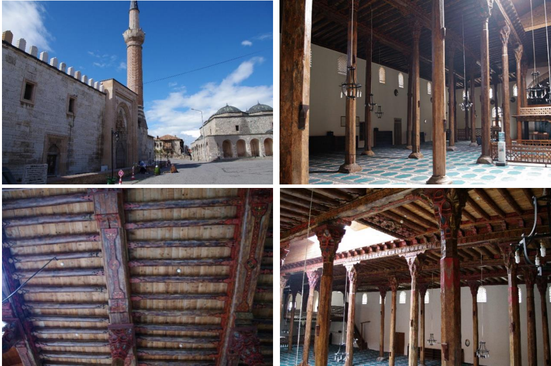
Şekil 1. Eşrefođlu Camisi dış ve iç görüntüsüne ait fotoğraflar (Foto: Bilgin İÇEL)
