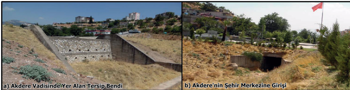
Foto 5: Akdere'nin Şehir Merkezine Girişte Kapalı Kanala Girişi.
