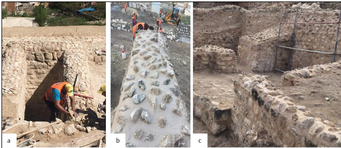
Şek. 18: Külliye Duvar Kalıntıları Üzerine Capping (Şapkalama) Yapılması Çalışmalarına Örnek (a, b, c).
