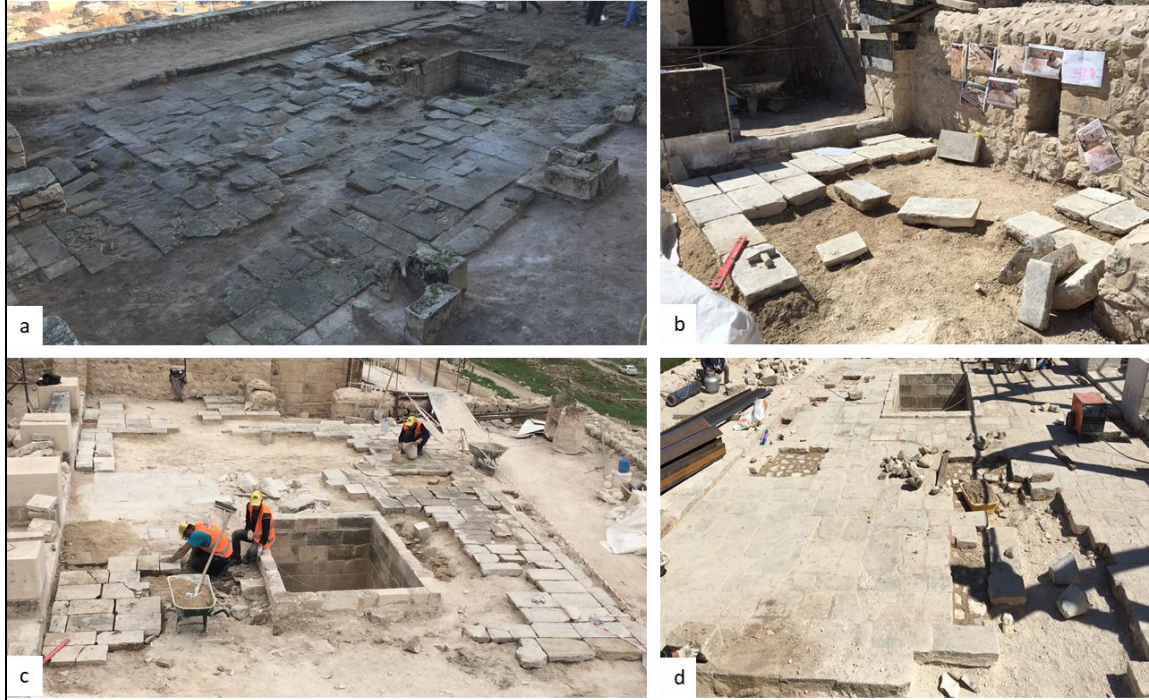
Şek. 19: Yamaç Külliyesi Güney (Cami) Bölümü Avlu Yonu Taş Taban Kaplamalarının Mevcut Durumu (a) ve Özgün Yerlerinde Mevcut Haliyle Sağlamaştırılma Çalışmaları (b, c, d).
