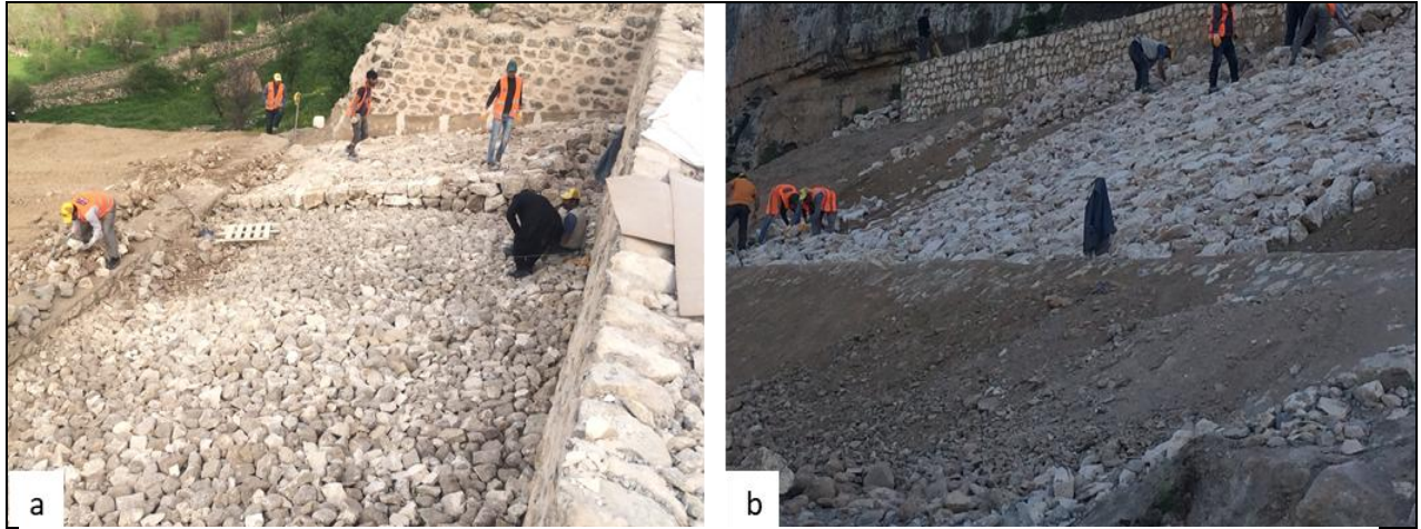
Şek 26: Külliye Kuzey (Medrese) Bölümü Kalıntılarının Su Altında Korunmasına Yönelik Son Uygulama Anroşman Katmanı Oluşturulma Çalışmaları (a, b).
