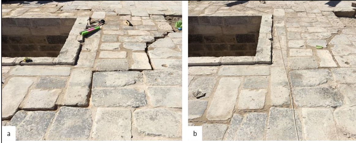
Şek. 20: Güney (Cami) Bölümü Avlu Taban Kaplamalarının Eksik Bölümlerine Yerleştirilen ve Özgün Yerlerinde Korunan Kaplama Taş Malzemelerin Birbirinden Ayrırt Edilebilmesi İçin Küçük Taşlar ile Belirtme Derzi Uygulaması (a, b).
