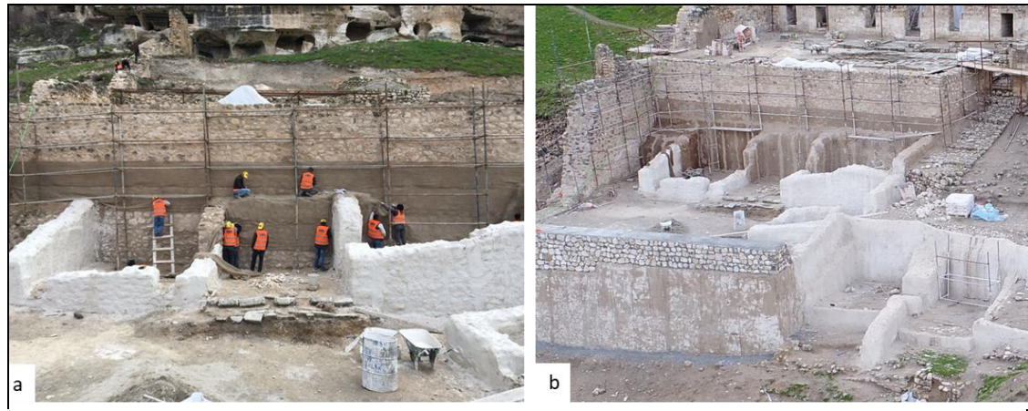
Şek. 24: Külliye Kuzey (Medrese) Bölümü Kalıntılarının Dolgu Katmanları Öncesinde Yüzeğe, Telis Bezi ve 5 cm Kalınlığında Hidrolik Kireç Harcı Malzeme İle Ayırıcı Katman Uygulaması, (a, b).
