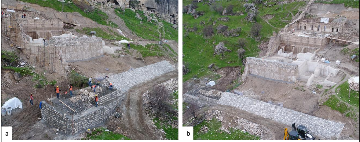
Şek. 22: Külliye Kuzey (Medrese) Bölümü Kalıntılarının Suyun Hareketine Karşı 1. ve 2. Set Duvarının Yapım Çalışmaları (a, b).
