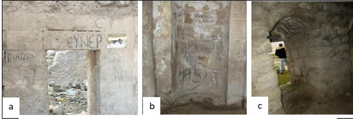
Şek. 14: Külliyesi Kalıntılardaki Bilinçsizce Yapılan Grafitiler Örnek (A, B) Ve Yüzeyinde Görülen Siyah İs Tabakalarına Örnek (c).
