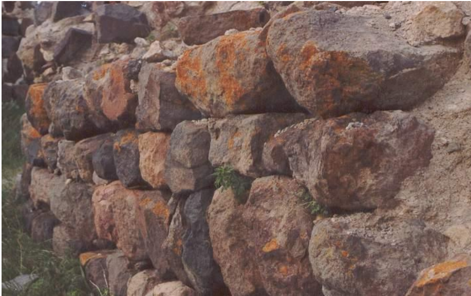
Resim-16 Koroğlu Kalesi Duvar Örgüsü
