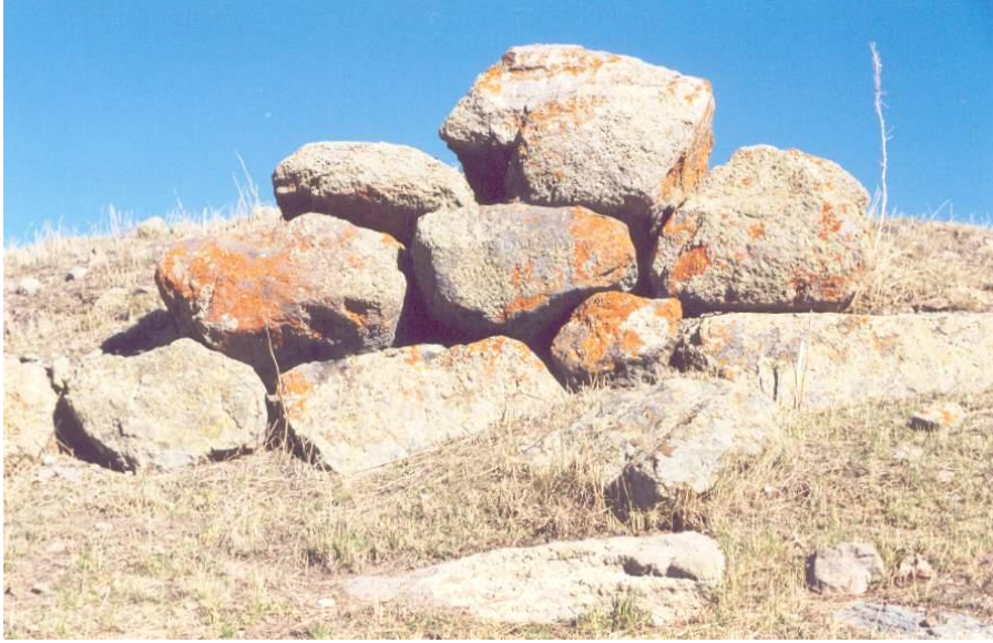
Resim-2 Toprakkale Kalesi Duvar Örgüsü
