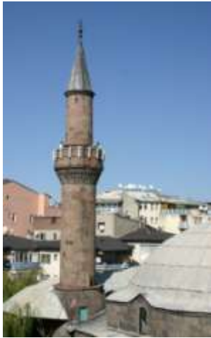
Resim 11:Şeyhler Cami Minaresi
