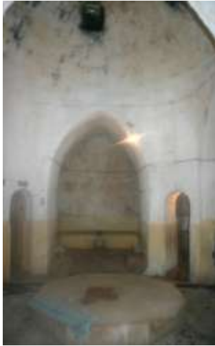
Resim 25: Hamamın Sıcaklık Bölümü Ocağı
