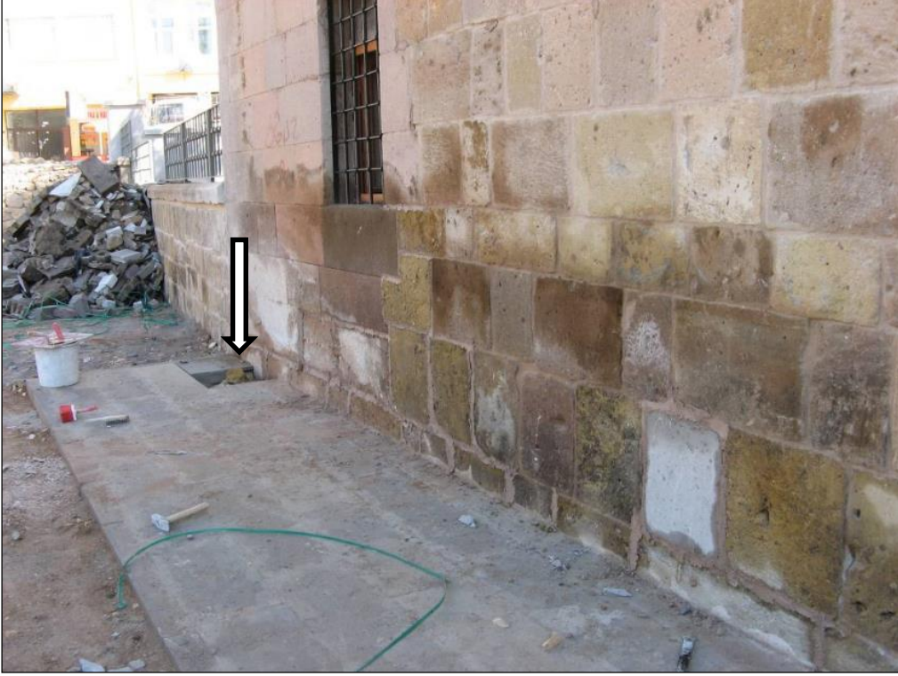
Şekil 13. Yapıda zemin suyuna bağlı kapiler yükselme bölgesindeki nemlenme etkilerine karşı alınan drenaj önlemleri
