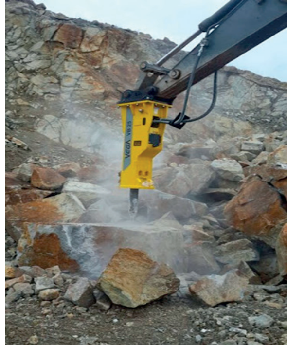
Şekil 1. Hidrolik kırıcı ile iri blok kırma işlemi
