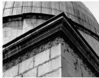
Resim 3. Ana mekânın saçak hattı Resim4. Saçak kornişi
