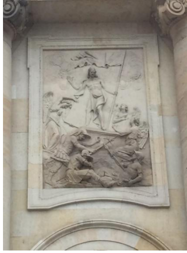
Res. 29: St. Hedwigs Kirche (Azize Hedwigs Kilisesi) Batı Cephesindeki 4. Pano.
