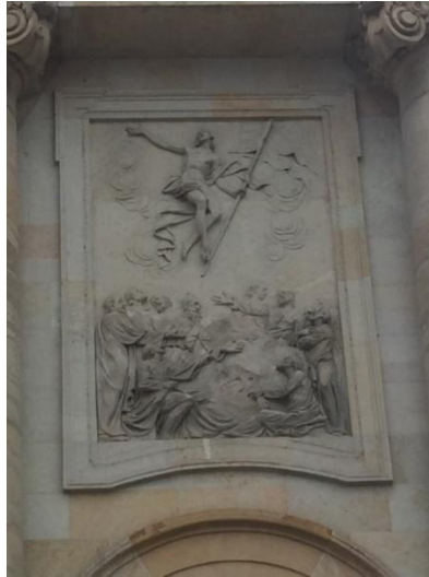
Res. 30: St. Hedwigs Kirche (Azize Hedwigs Kilisesi) Batı Cephesindeki 5. Pano.
