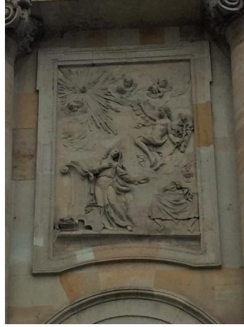
Res. 26: St. Hedwigs Kirche (Azize Hedwigs Kilisesi) Batı Cephesindeki 1. Pano.
