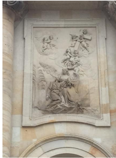
Res. 27: St. Hedwigs Kirche (Azize Hedwigs Kilisesi) Batı Cephesindeki 2. Pano.
