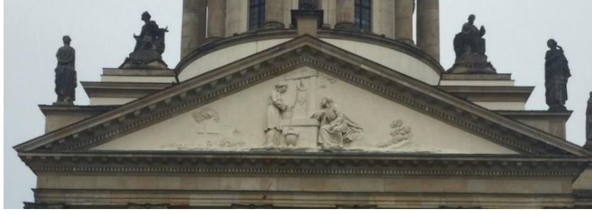
Res. 34: Frazösischer Dom (Fransız Katedrali) Güney Cephesindeki Alınlık.
