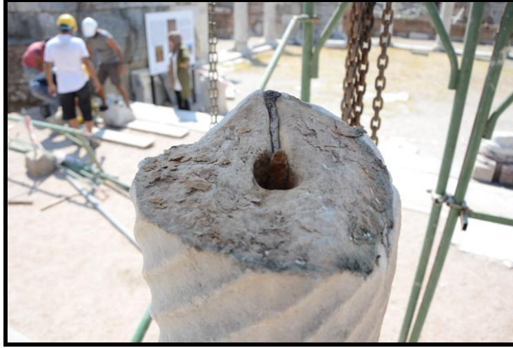
Res. 12: 1963 yılı hatalı kurşun sabitleme uygulaması ve işlevini yitirmiş, pul pul olmuş polyester esası yapıstırıcı sütun gövdesi üst yarısı kaldırıldıktan sonraki görünümü (Kazı Arşivi).
