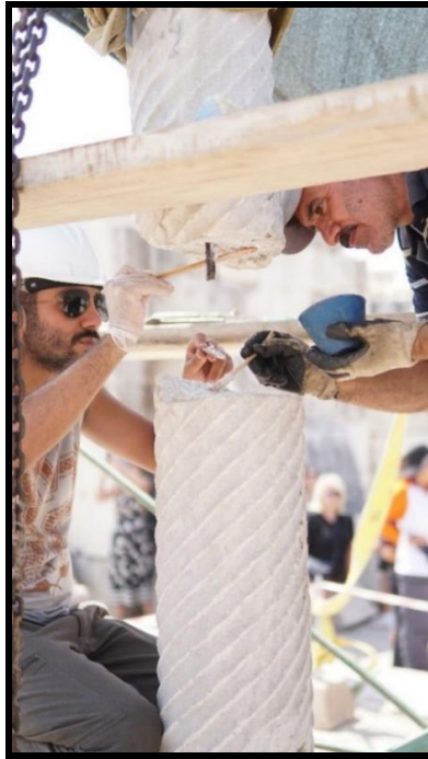
Res. 13: Sütun gövdesi birleştirilmeden önce yüzeye epoksi sürülürken (Kazı Arşivi).
