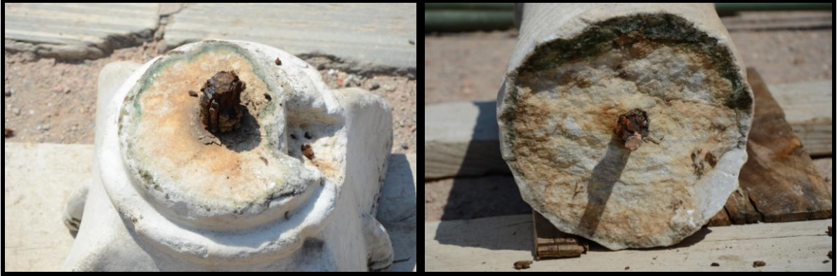
Res. 9: Kiborion güneybatı sütun ve başlığı ayrılan noktalarda görülen bozulmalar (Kazı Arşivi).
