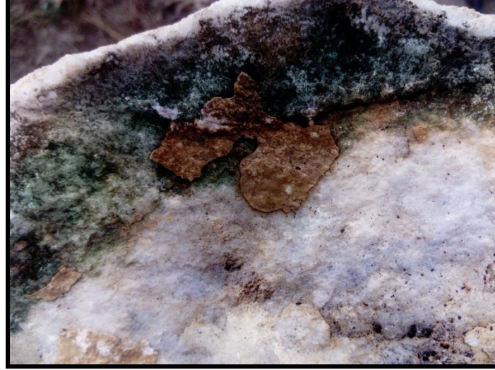
Res. 16: Polyester esaslı yapıştırıcı kabuk gibi dökülmesinin ardından birleşim alanı yosunlanma, kirlilik ve kabuklaşmış yapıştırıcı (Kazı Arşivi).
