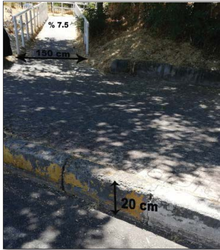
Şekil 7b. Üniversite Hastanesi alan rampa girişi
