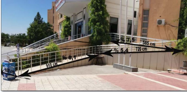
Şekil 2d. Eğitim Fakültesi bina giriş rampası
