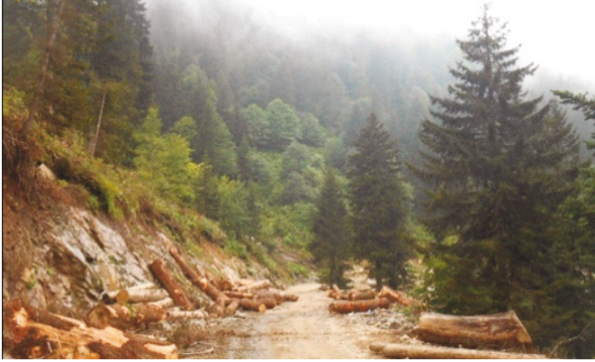
Şekil 14. Araştırma sahasının orta kesimindeki ormanlar ve yol genişletme çalışmaları (Mesudiye, Köşe köyü mevki).
