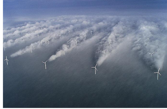
Şekil 10. Deniz üstü rüzgâr çiftliğinde Wake etkisi (Horn Rew / Danimarka) (Sun vd., 2012) Figure 10. Wake effect on the offshore wind farm (Horn Rew / Danimarka) (Sun vd., 2012)
