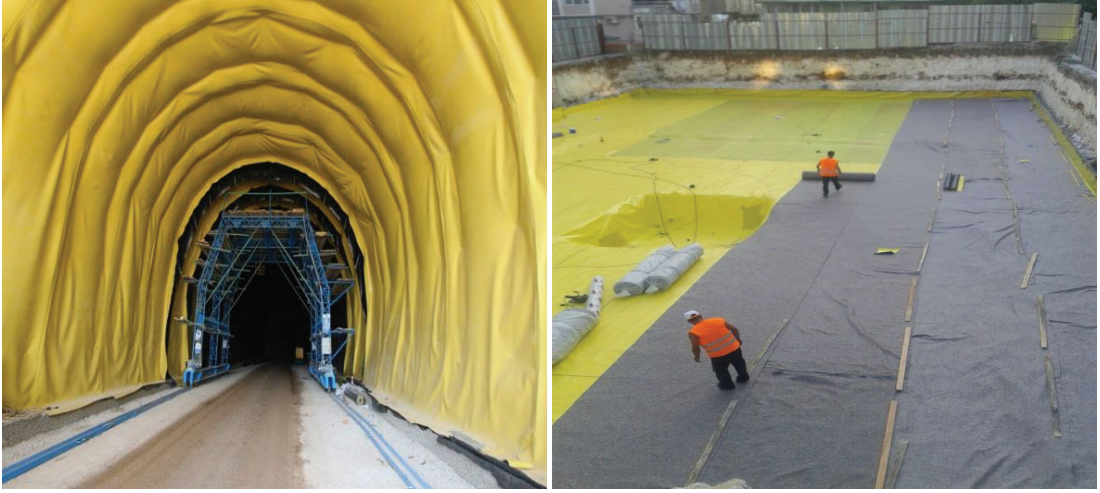
Resim 3.3 Sentetik su yalıtım örtü uygulaması.
