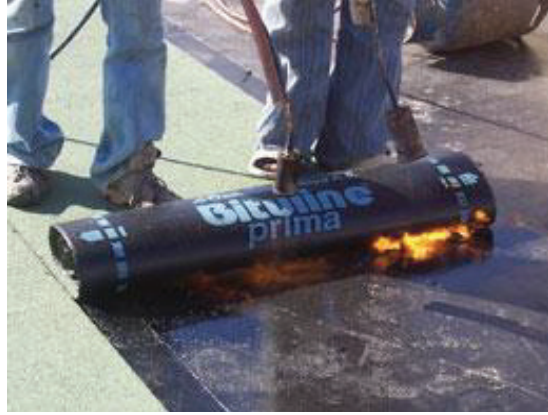
Şekil 3.2 Plimer bitümlü örtülerin uygulaması
