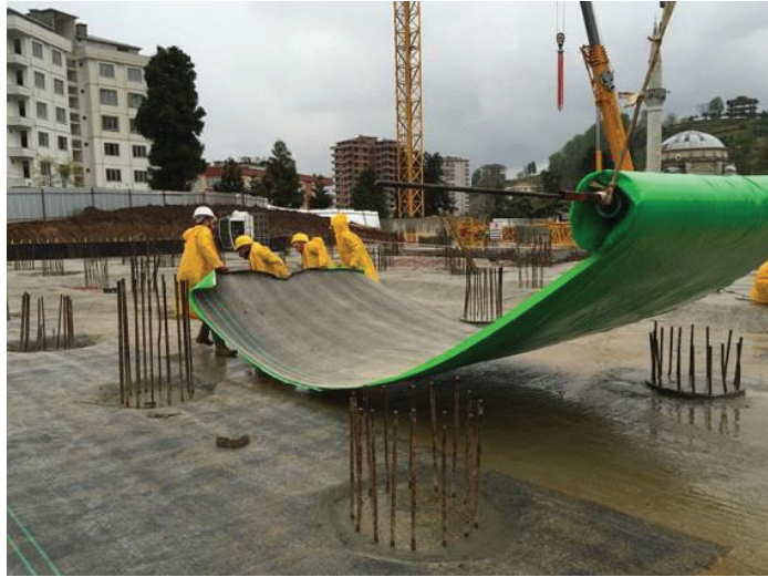
Şekil 3.4 Bentonit şilte uygulaması.
