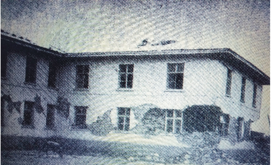
Resim-6. 1971 Bingöl Depremi'nde Hükümet Konağı'nın Gördüğü Hasar
