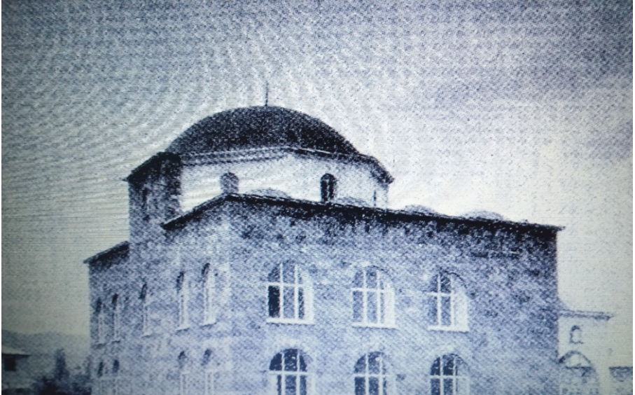
Resim-8. 1971 Bingöl Depremi'nde Minaresi Yıkılmış Olan Yeni Camii(Hacılar Camii)
