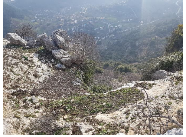
Şekil 1. Karahıdırlı Mahallesi kaya düşmesi
