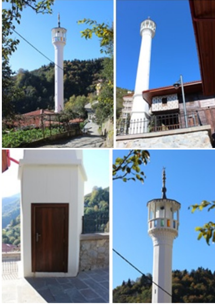
Resim 8. Güney Mahallesi Camisi, minareden ayrıntılar.
