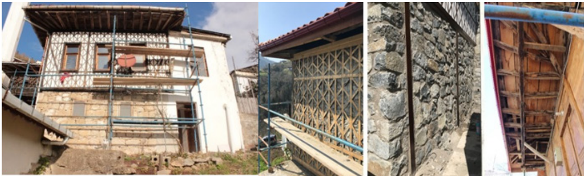
Resim 31. Medresenin cephelerinde yapılan imalatlar.
