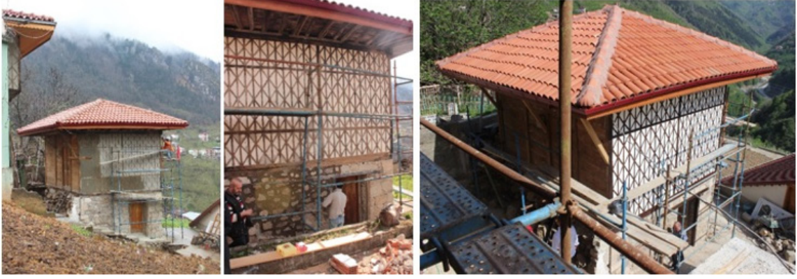
Resim 32. Medresenin cephelerinde yapılan imalatlar.
