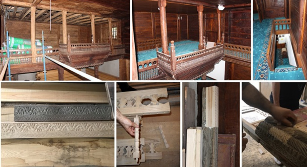
Resim 24. Mahfil katında yapılan imalatlar.
