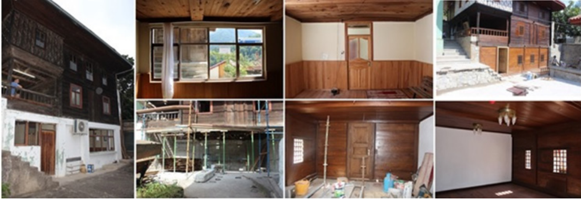
Resim 20. Bodrum kat imalatları.
