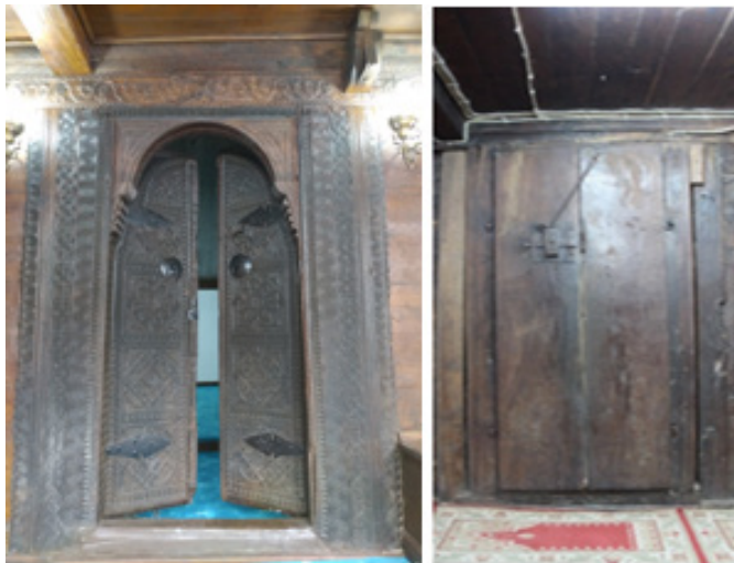
Resim 16. Güney Mahallesi Camisi kapı süslemeleri.
