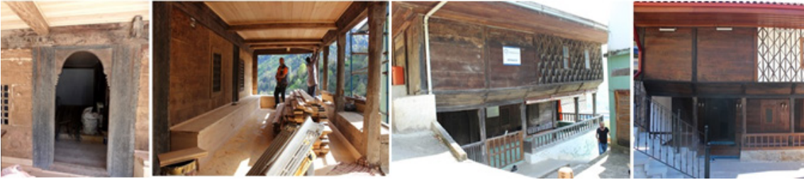
Resim 21. Son cemaat alanında yapılan imalatlar.
