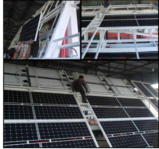
Şekil 7. Güneş pillerine ait montaj görüntüleri
