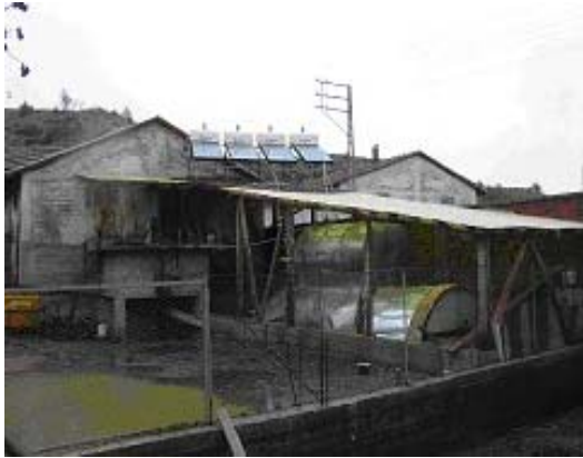
Şekil 6. Tesisin genel görünümü ve güneş kolektörleri
