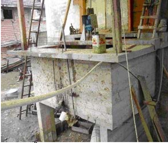
Şekil 1. Ön karışım havuzu ve karıştırma düzeni
