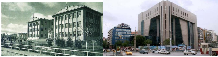
Şekil 4. Soldaki; 1979'daki (Kılıç, 2009); sağdaki; yeni Kızılay binası.
