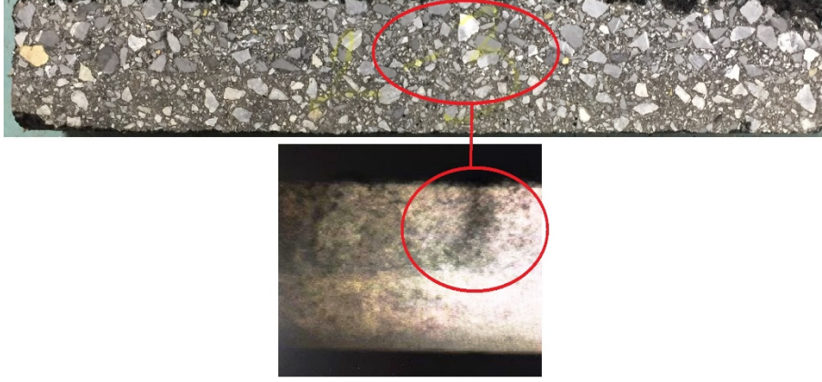
Şekil 4. MA+TMA Numunesinin Çatlak Görüntüsü
