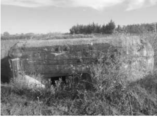
Ek 12. b. Büyükçekmece- Eskice Çiftliği yolu solda göle yaklaşık 300 metre uzaklıkta. İkinci tip koruganların çatı ve duvarları birinci tip koruganlara göre daha kalın olup bunların tek penceresi ve kapısı vardır. Buldukları konuma göre içerisinde sadece top ya da ağır makineli tüfek bulunur. Konumu ve stratejik önemine göre bu koruganlarda havalandırma sistemi olabilir.
