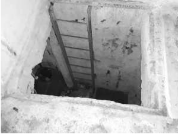
Ek 18. f. Çatalca Dağyenice Köyü, yukarıdaki fotoğrafta (Ek 18.d.) görünen tünel girişinden yaklaşık 300 metre ileride üçüncü tip koruganın zemin katının altında sığınak ve sığınakın altından tünele bağlanan kare biçiminde yapılmış mühimmat geçiş bağlantı noktası vardır.
