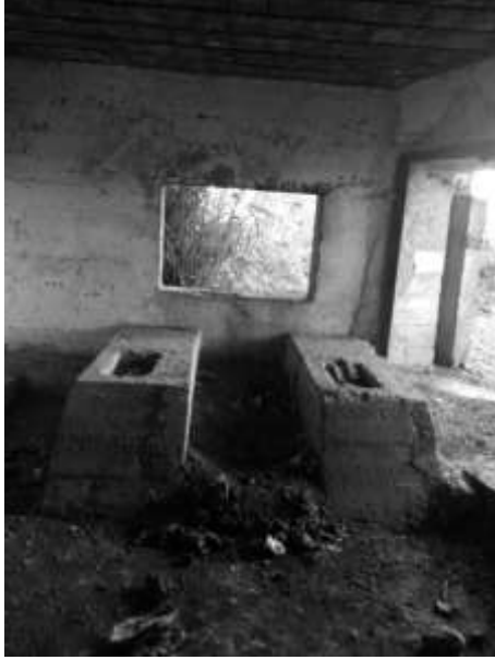
Ek 15 l. Üçüncü tip koruganda topların yerleştirildiği düzenek ve pencere.
