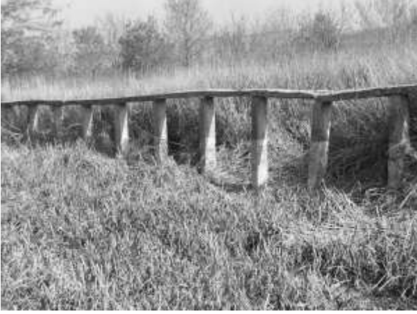
Ek 21. d. Bahşiyiş Köyü tankların geçişini engellemek için içinde demir bulunan birbirlerine bağlı ejderdişleri. Daha önce bu ejderdişlerinin önünde derin kazılmış bir hendek vardı. Ancak zamanla bu hendek dolduruldu.
