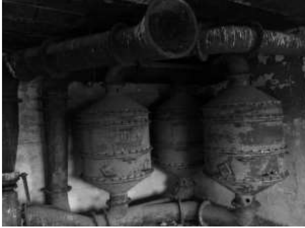
Ek 13. b. Üçüncü tip korugan havalandırma düzeneği.
