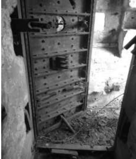
Ek 15. f. Demirden yapılmış, üçüncü tip koruganın iç kapağı.
