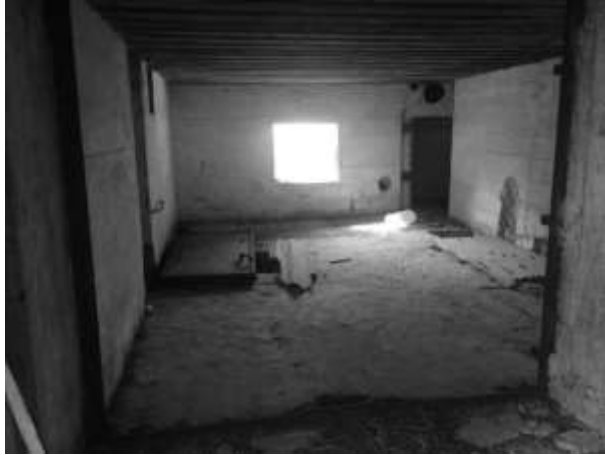
Ek 16. i. Dördüncü tip korugan topların yerleştirildiği kapıdan koruganın içi. Solda sığınağa inilen kısım.
