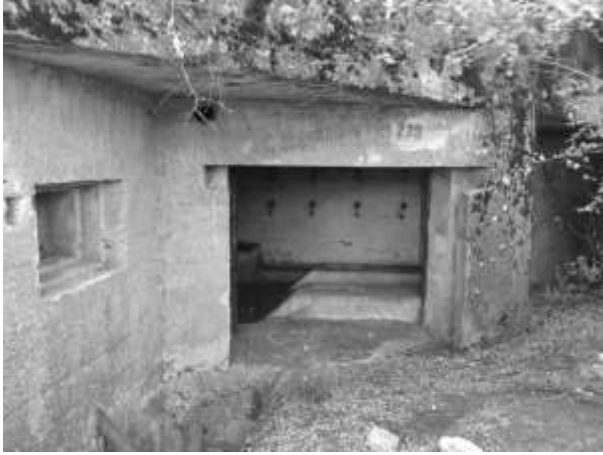
Ek 15. k. Üçüncü tip koruganlarda topların içeriye alındığı kapı ve topların yerleştirildiği beton düzenek.
