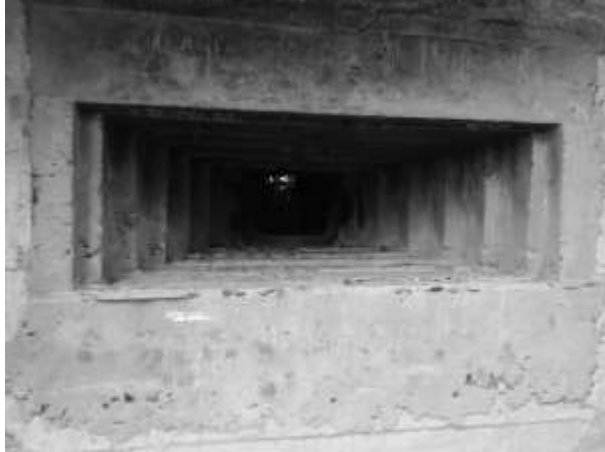
Ek 15. m. Üçüncü tip koruganların duvar kalınlığı hakkında bilgi veren pencere.
