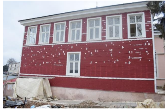
Fotoğraf 3: Hünkâr Kasrı Batı Cephe
