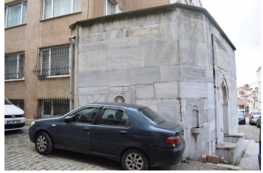
Fotoğraf 27: Kaptan Paşa Çeşmesi Güney Cephe
