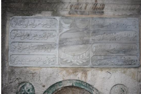
Fotoğraf 41: Çeşme Onarım Kitabesi
