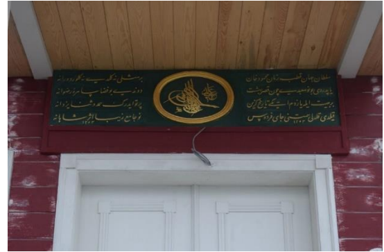
Fotoğraf 4: Mescid Onarım Kitabesi
