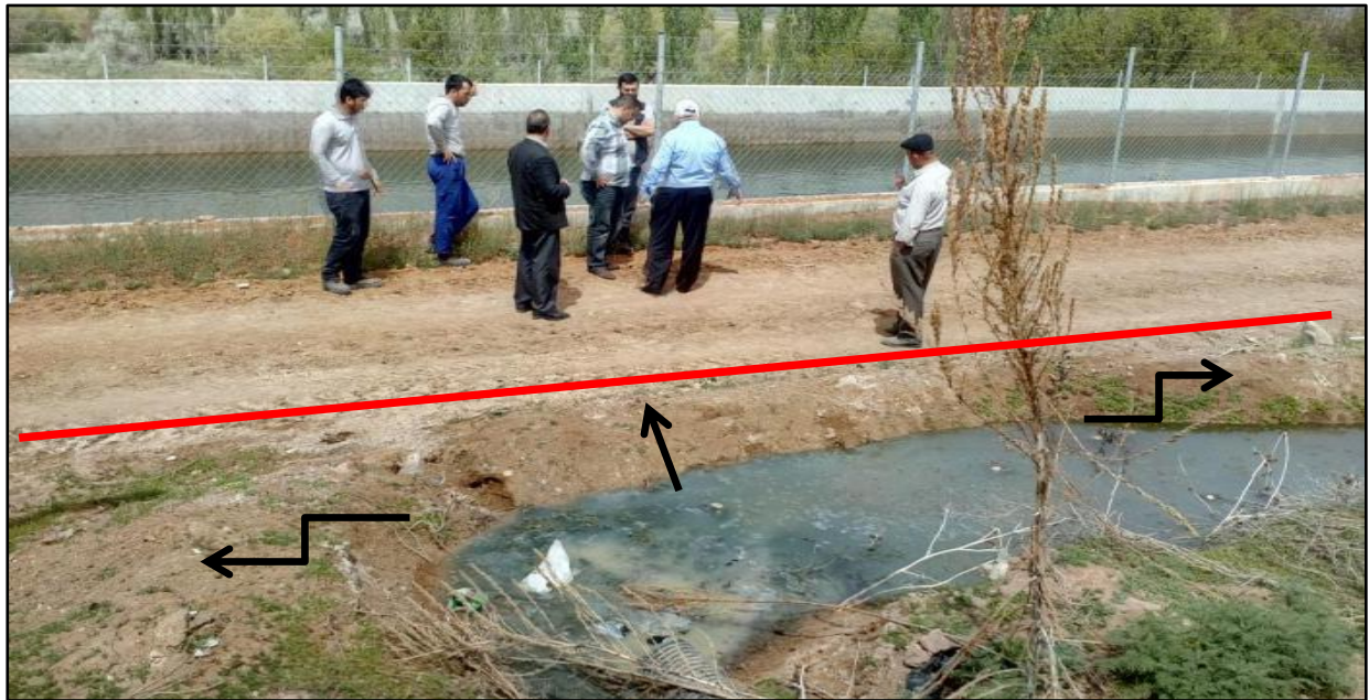
Şekil 8. Geçirimsiz yeşil renkli kiltası seviyesi ve üzerindeki iletim kanalı nedeniyle geçirimsiz bariyer oluşması ( Impermeable barrier formation due to impermeable green colored claystone level and the transmission channel on it ).
