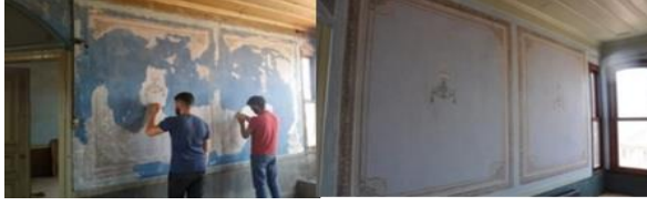
Şekil.44- Dalyancı Konağı İç Mekân Restorasyon Çalışmaları
