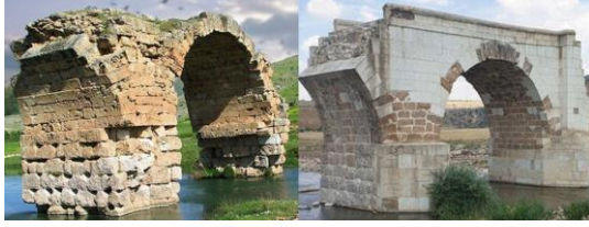
Şekil.4-Gaziantep Septimius Severus Köprüsü Restorasyonu
