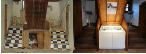
Şekil.34- Yağcızade Konağı İç Mekân Restorasyon Çalışmaları
