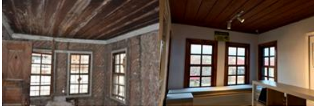
Şekil.35- Yağcızade Konağı İç Mekân Restorasyon Çalışmaları
