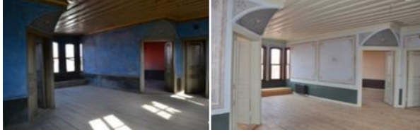
Şekil.43- Dalyancı Konağı İç Mekân Restorasyon Çalışmaları
